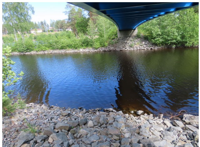
Kuva 16. Kanavan molemmat rannat on eroosiosuojattu kookkaalla sepelillä.
